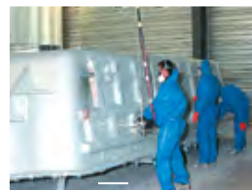
Pose des renforts + résine de protection
