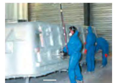
Pose des renforts + résine de protection
