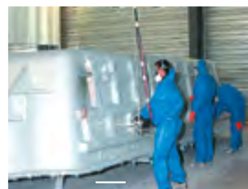
Pose des renforts + résine de protection
