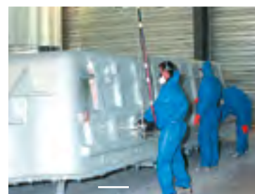
Pose des renforts + résine de protection
