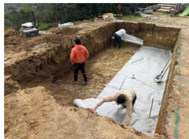
3/ Pose Géotextile
