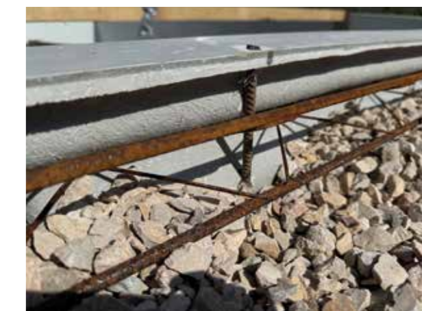
9/ Suite remblaiement - Ferrailage
