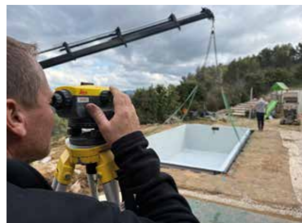
6/ Mise en fond de fouille - Mise à niveau
