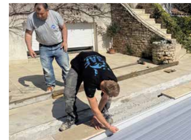
11/ Pose des margelles
