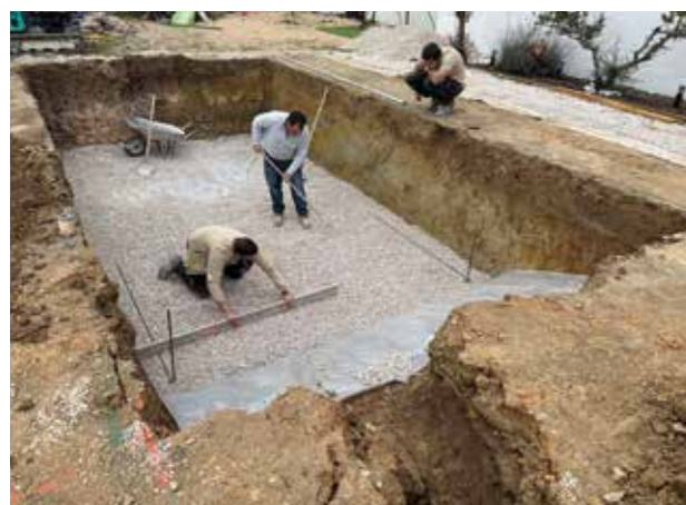
4/ Assise - Tirage radier
