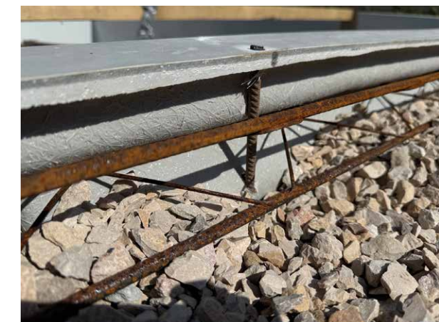
9/ Suite remblaiement - Ferrailage
