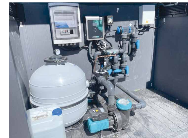
12/ Réalisation local technique
