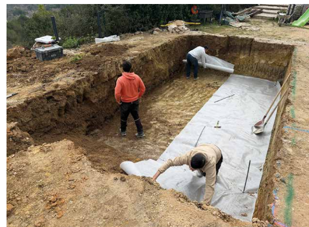
3/ Pose Géotextile
