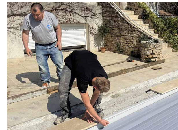
11/ Pose des margelles
